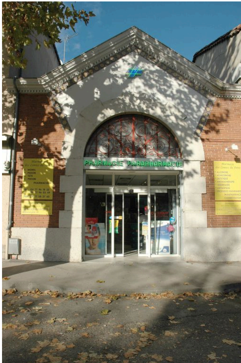
Boulevard Gambetta, l'ancienne distillerie Pichon devenue pharmacie.
