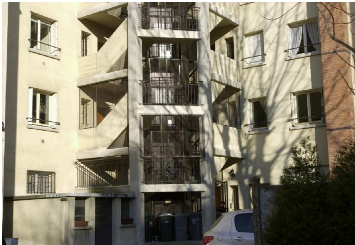
Vue de l'escalier de service hors-oeuvre en façade postérieure
