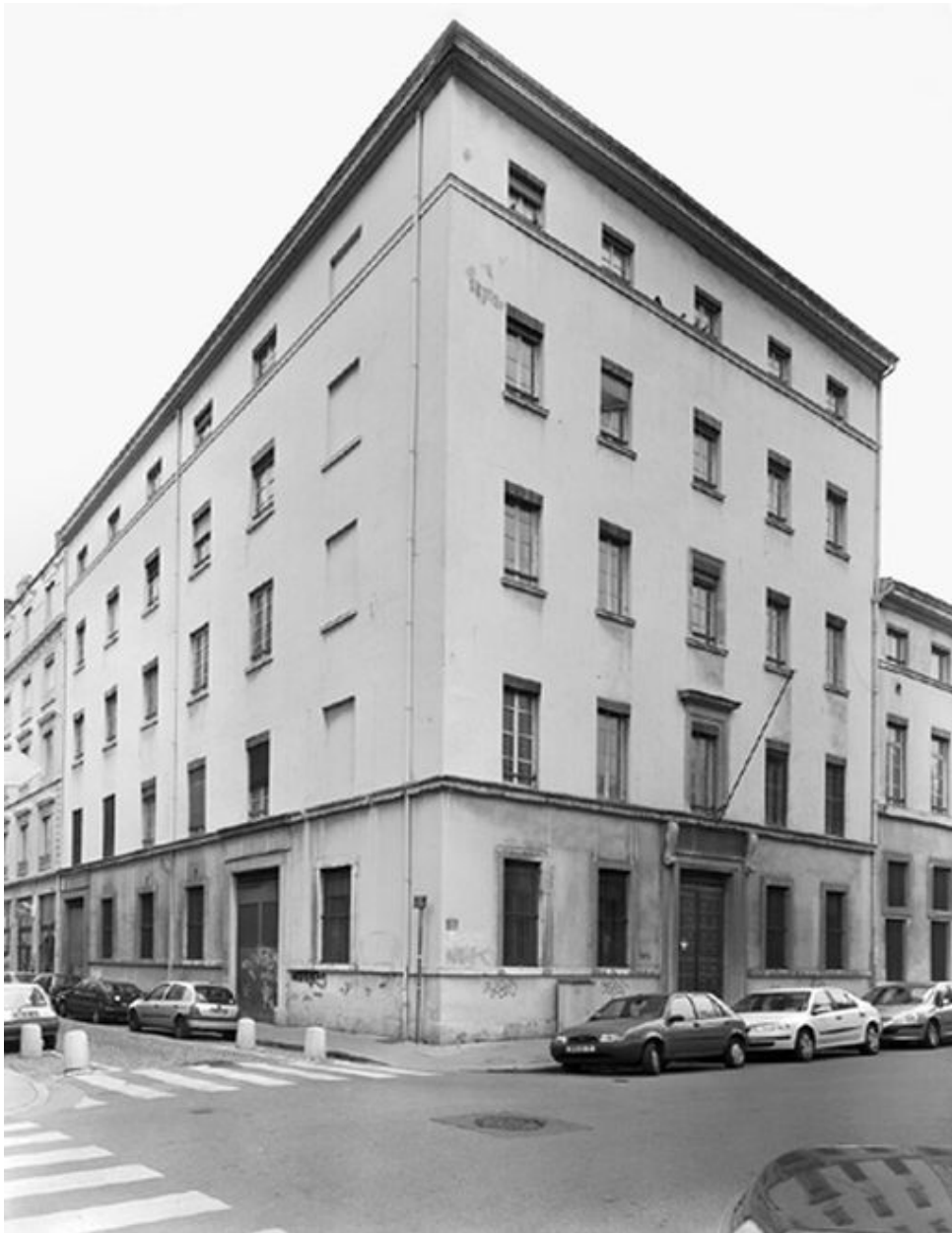
Ancien immeuble, vue générale
