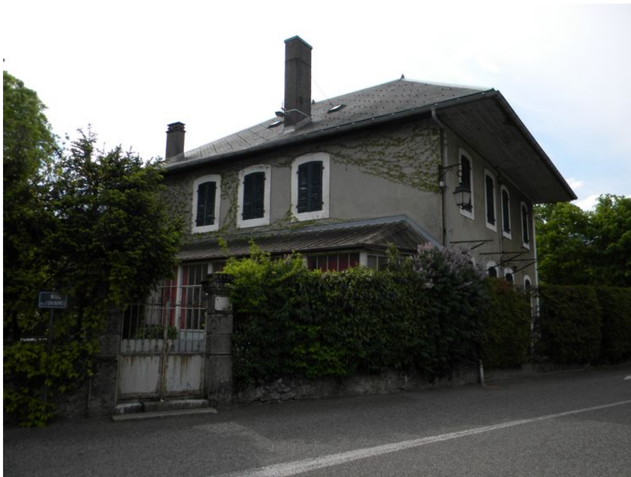
Vue de la façade nord.
