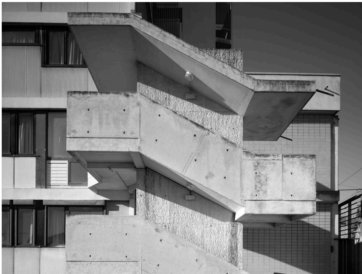
Escalier extérieur, situé au nord du bâtiment E. Détail. Noir et blanc.
