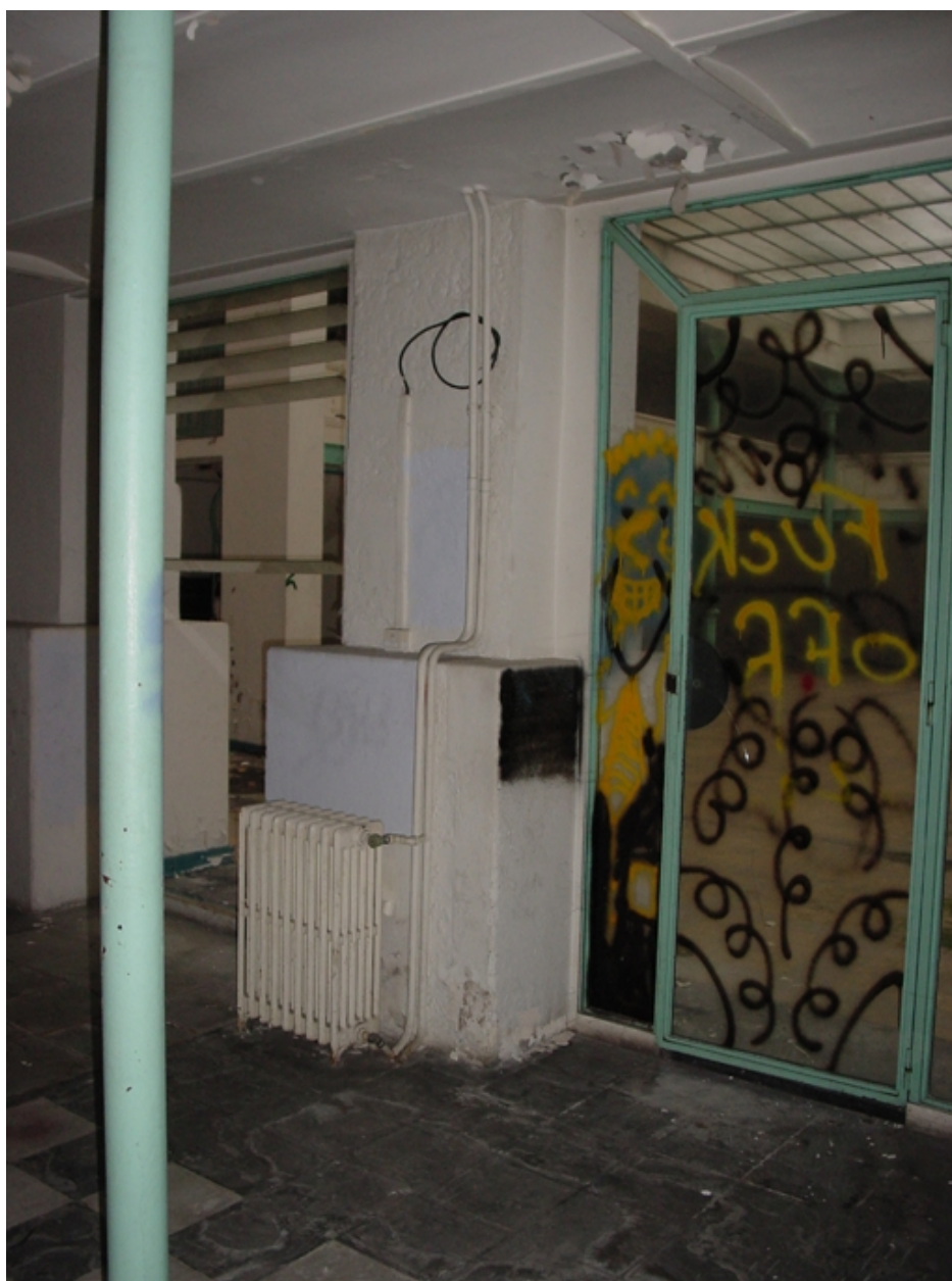
Espace latéral à la grande halle
