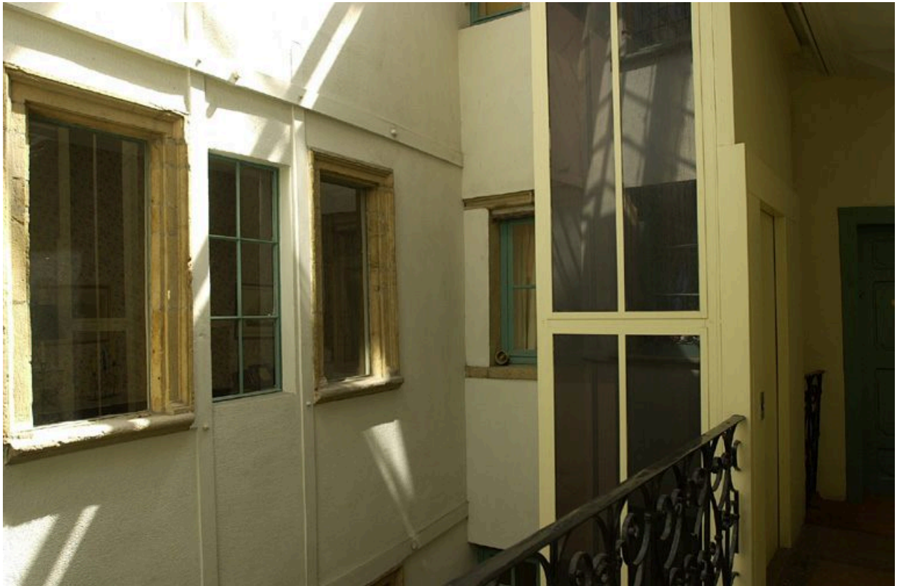
Corps de bâtiment nord sur cour : détail de baies depuis le palier de l'escalier
