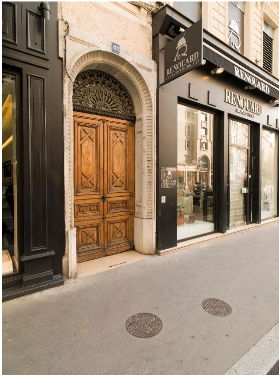
Elévation antérieure : le rez-de-chaussée, vue partielle
