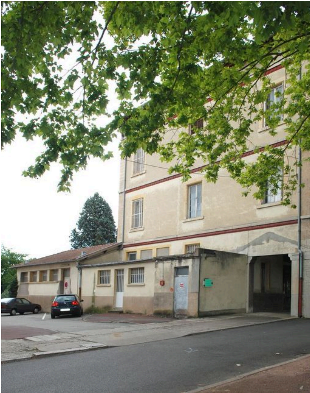
Façade latérale nord : le bâtiment et son ajout du milieu du 20e siècle
