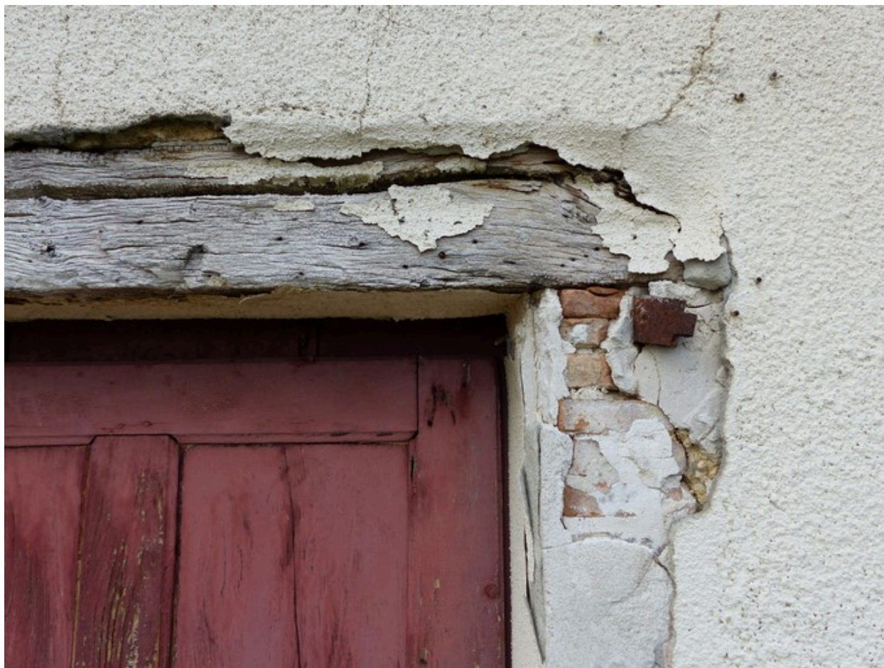
Bâtiment du logis. Elévation ouest, deuxième niveau. Porte, détail de l'encadrement.
