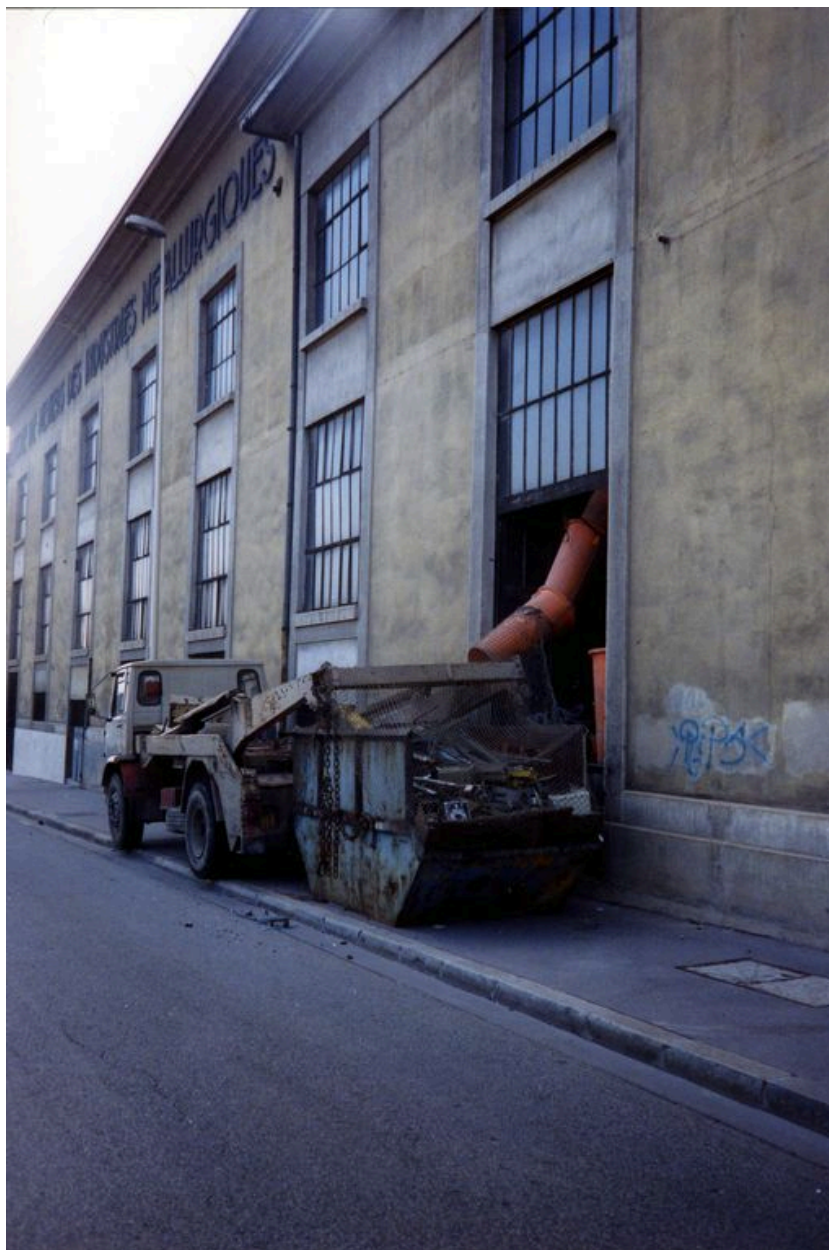
Façade principale au début des travaux, 1992
