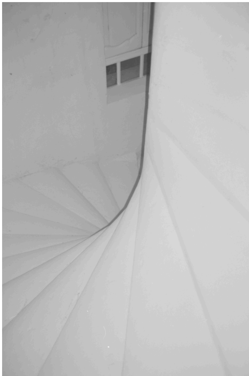
Détail de l'escalier et porte du rez-de-chaussée surélevé.
