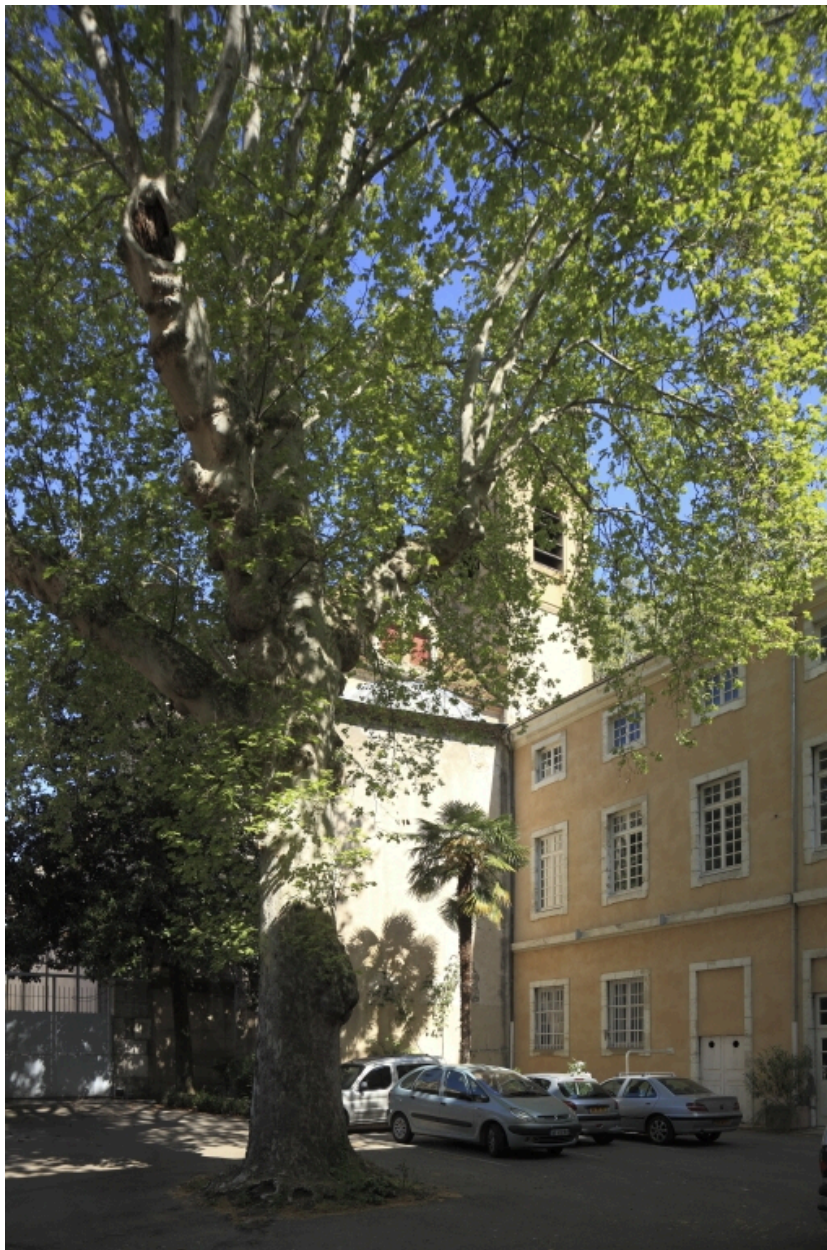
Bâtiment C. Façade occidentale et chevet de l'église, depuis le parc.
