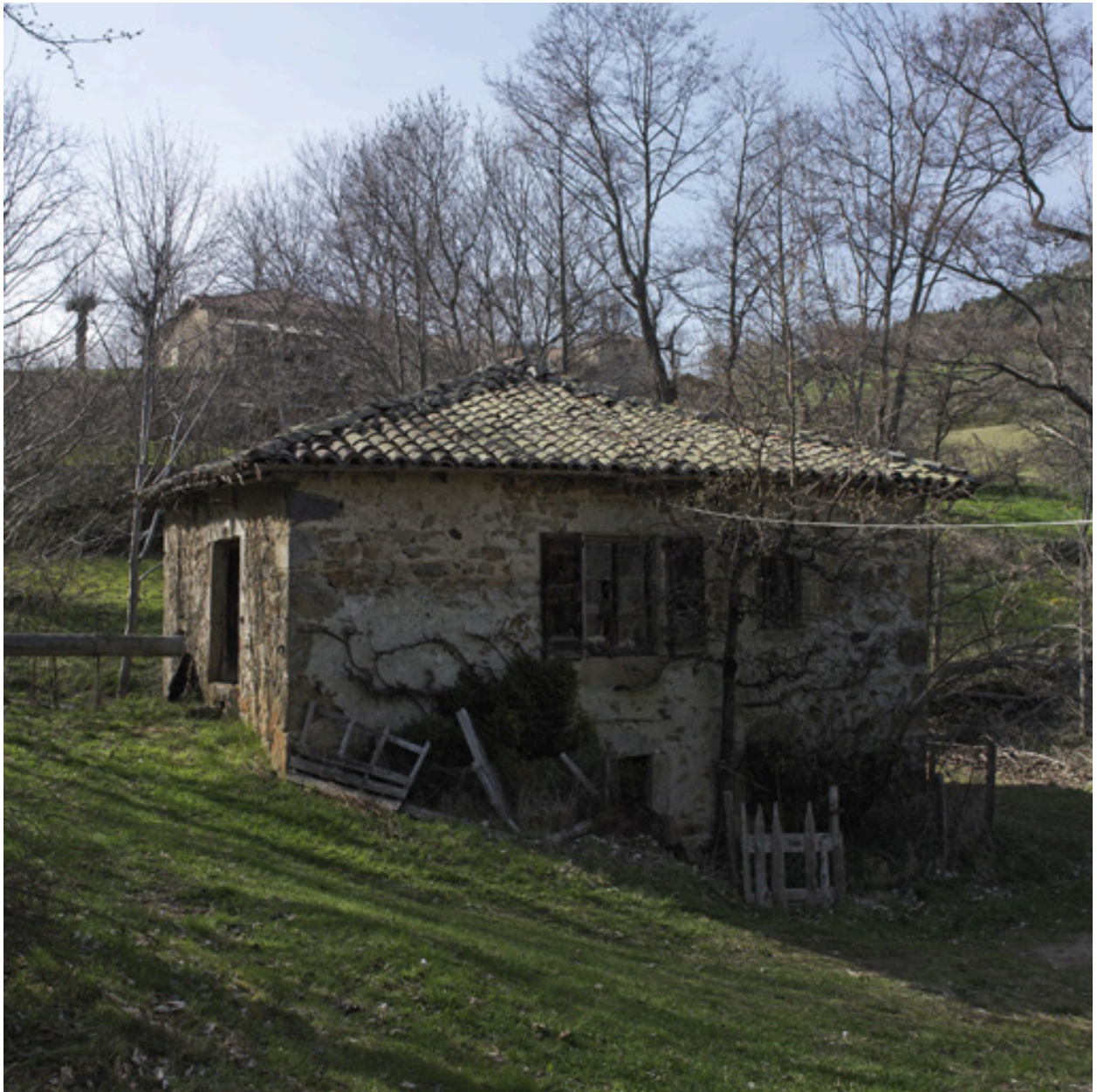
Vue d'ensemble de trois-quarts sud-est.
