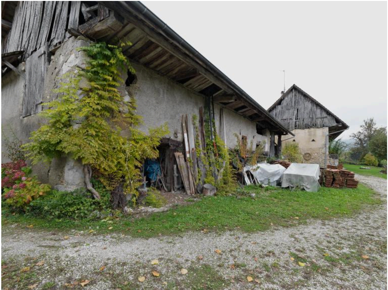
Vue d'ensemble de la grange-étable depuis le sud.
