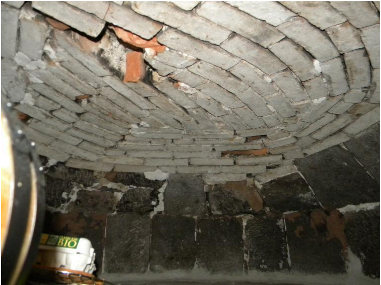
Détail de la voûte du four.
