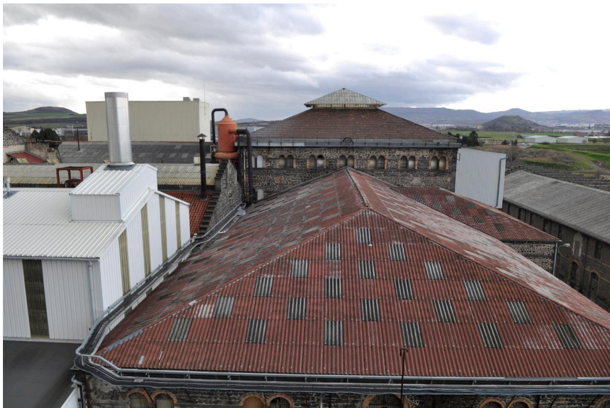
Vue de l'extérieur : détail toiture lanterneau
