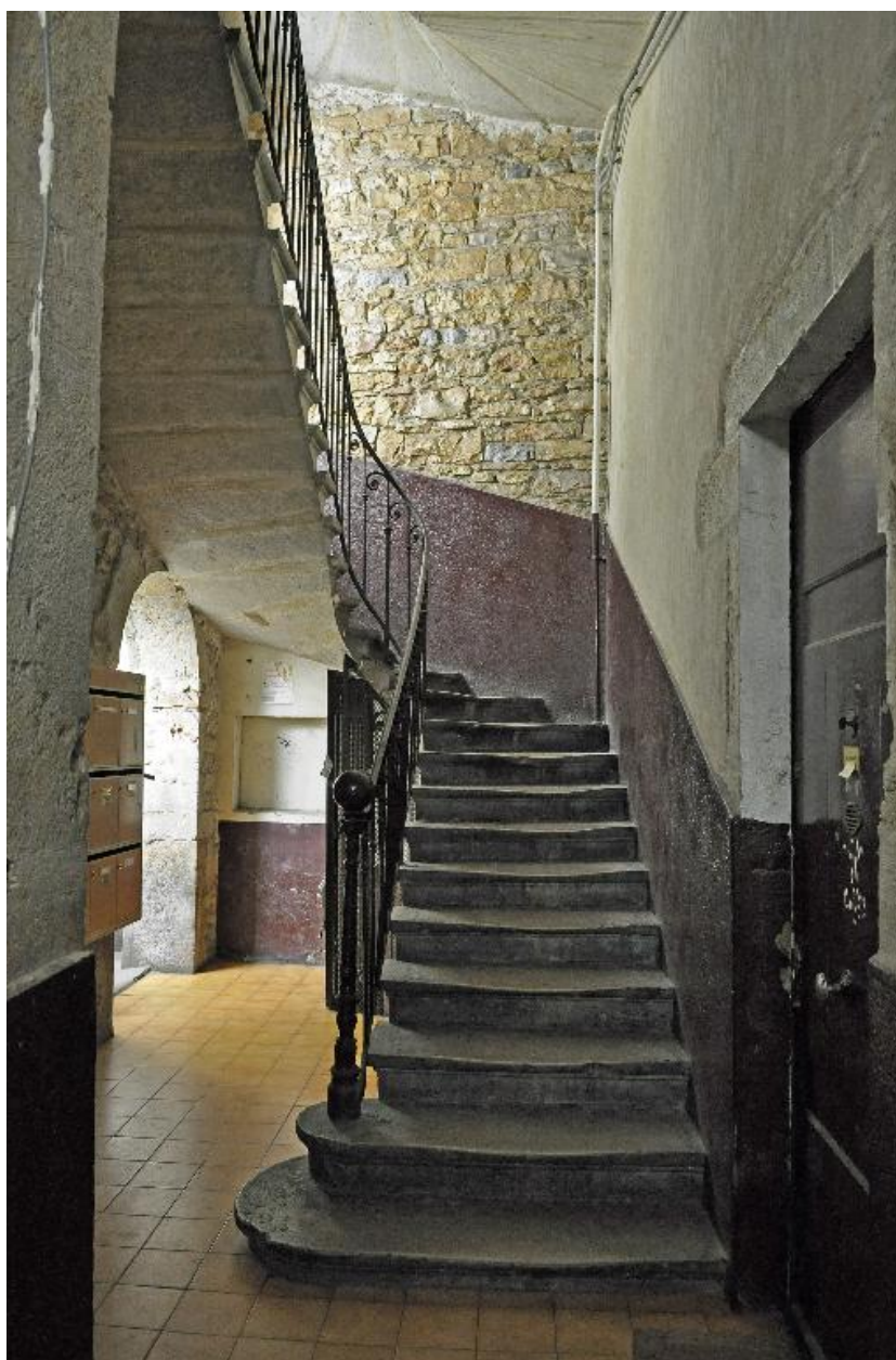
Vue intérieure : le départ de l'escalier
