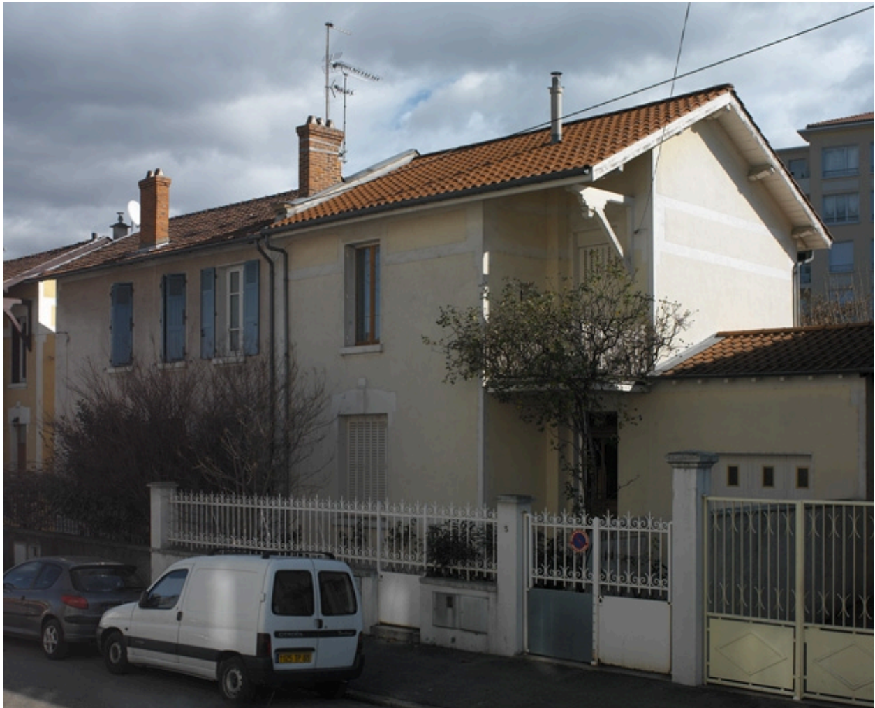
Vue sud-ouest, 9, 7 rue Littré (BP 63, 64), maison double modifiée par un garage sud-ouest pour la 9, et un agrandissement nord-est pour la 7
