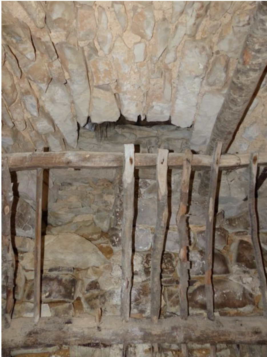
Etage de soubassement, étable. Mur nord, travée ouest. Râtelier et trappe d'abat-foin.
