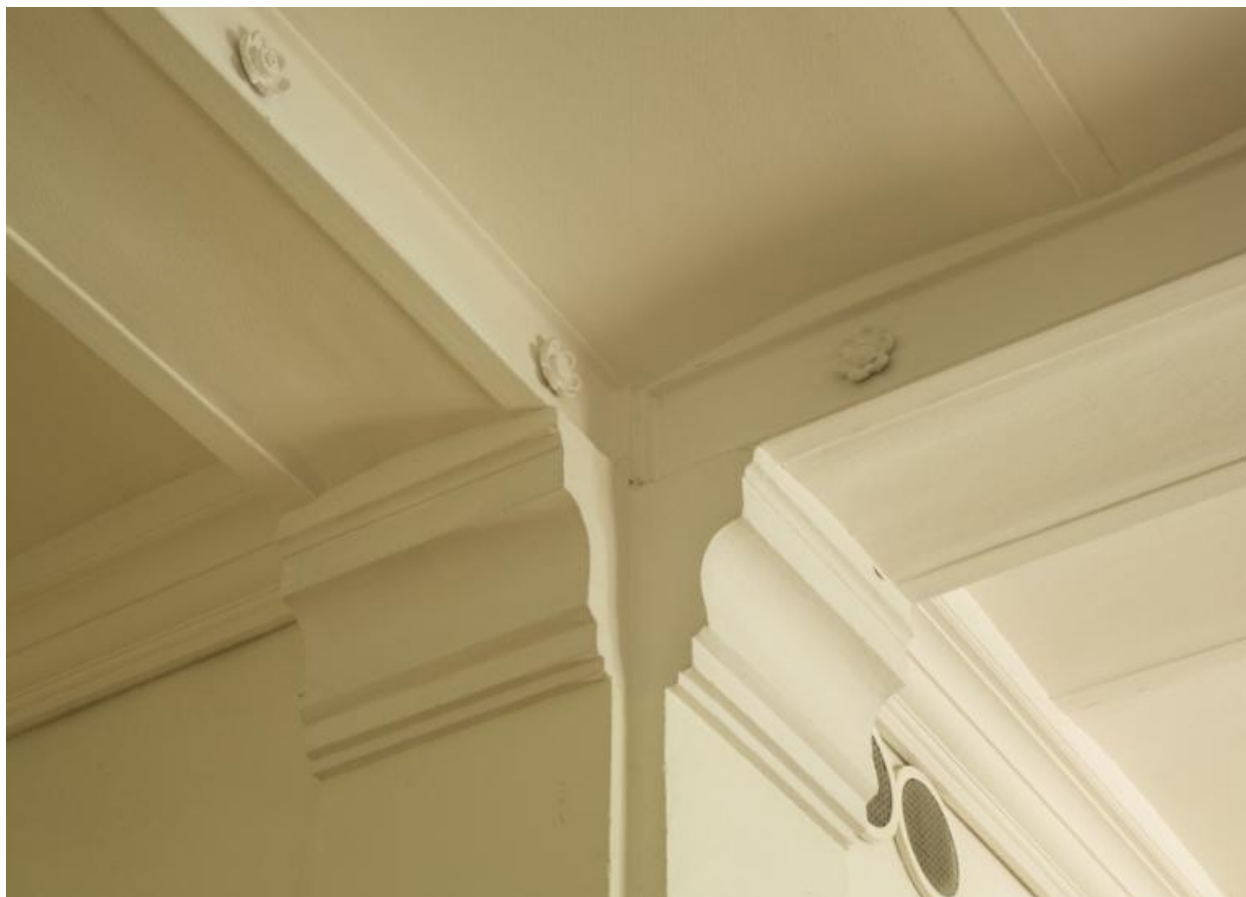
Pavillon Minerve. Modénature. Poutraison en acier et têtes de clou en forme de fleur.
