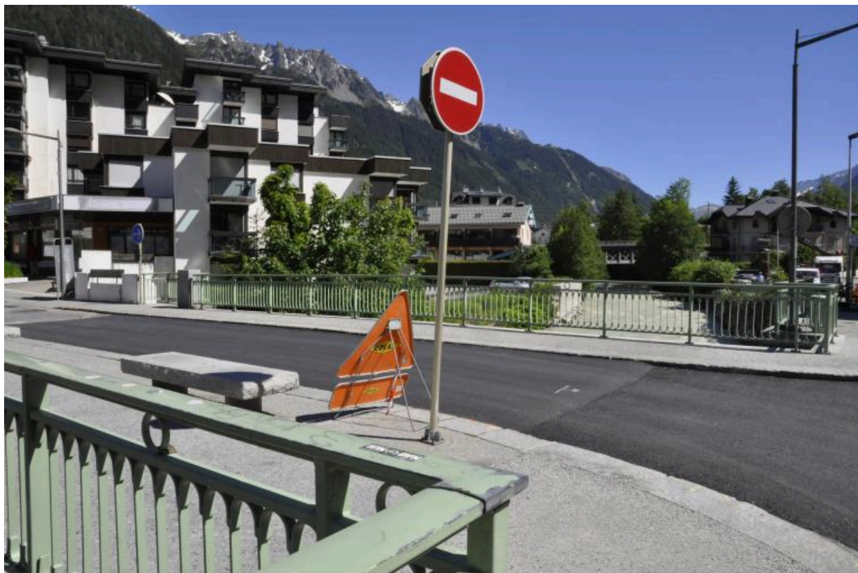
Vue de la chaussée de l'ouvrage
