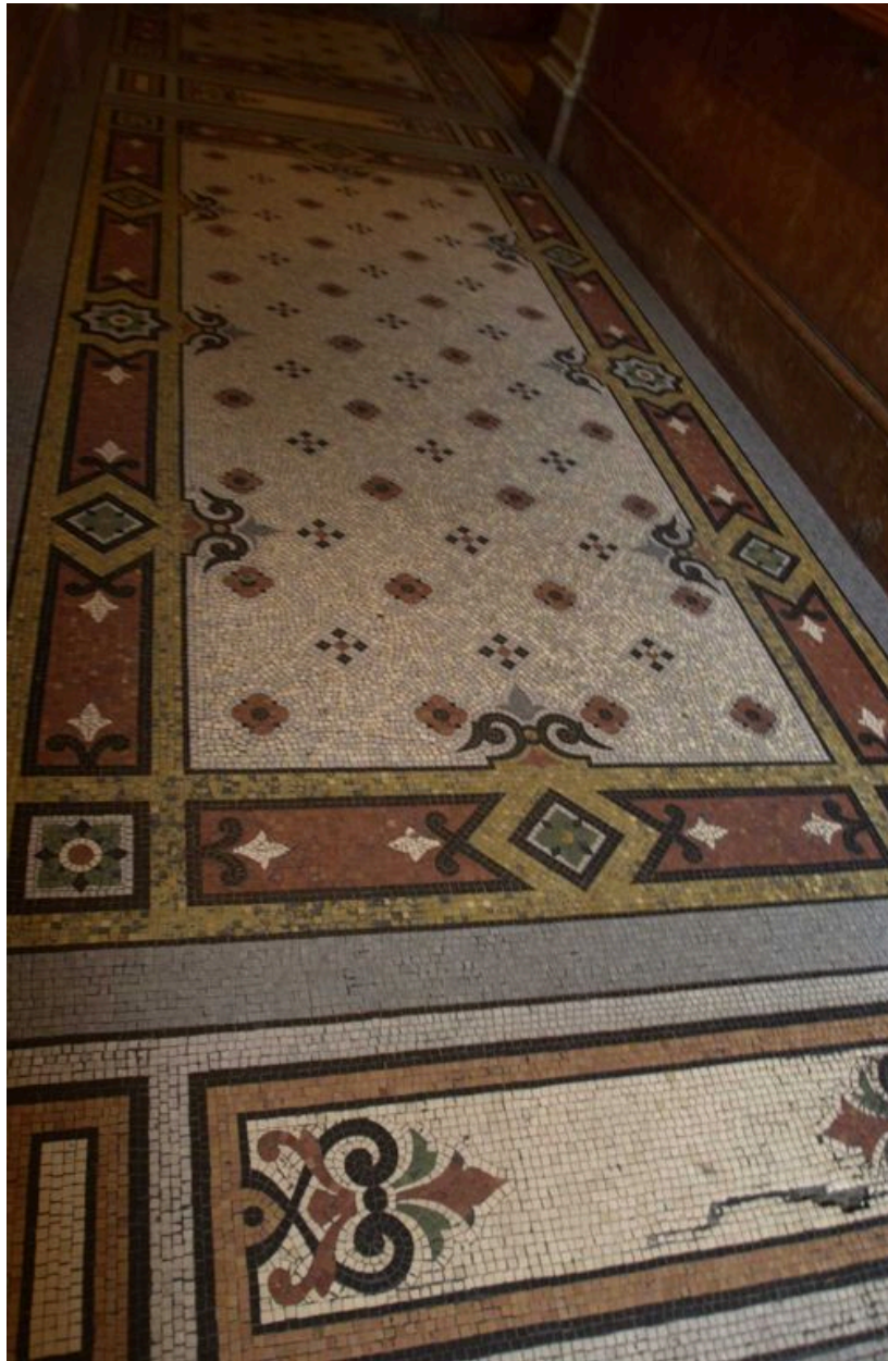
Pavement en mosaïque du vestibule
