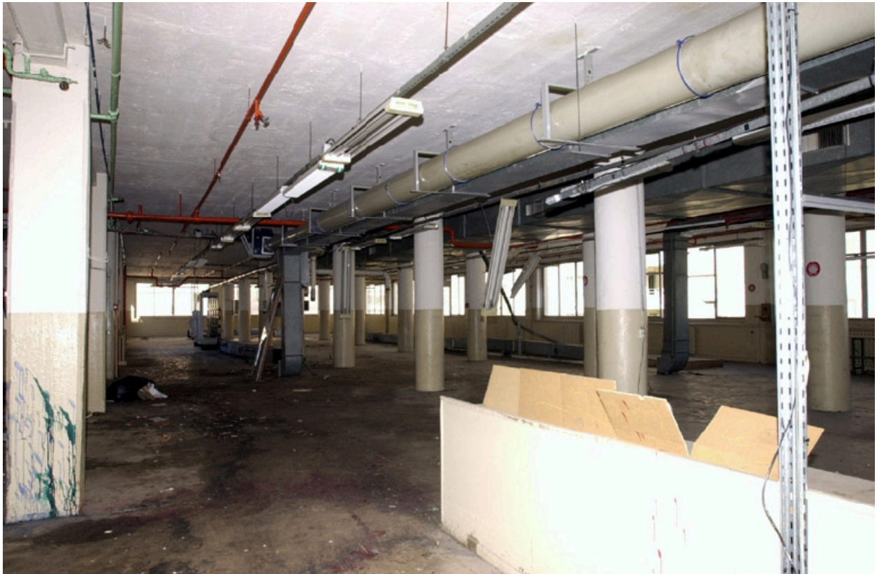
Vue de l'atelier du rez-de-chaussée
