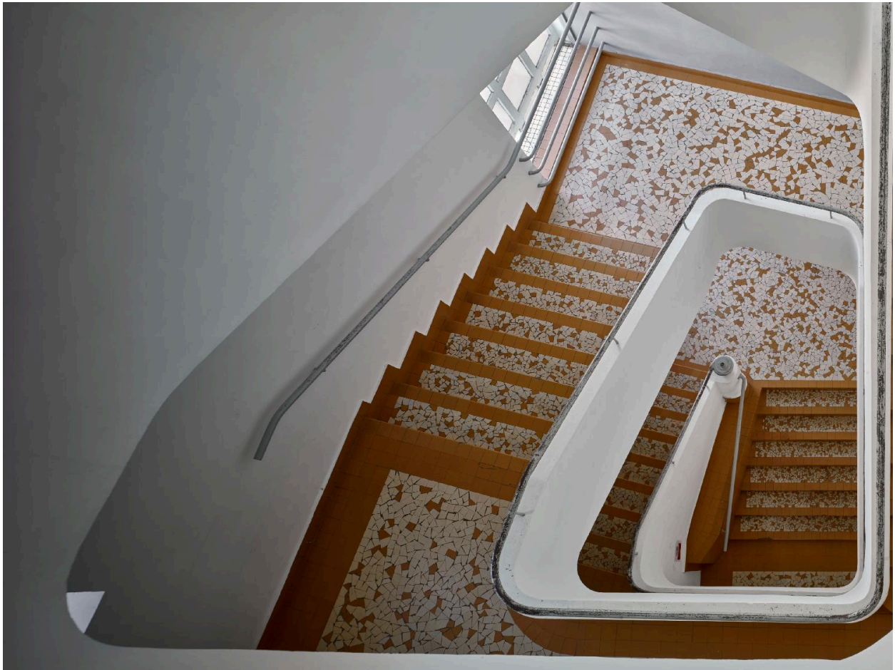
Escalier tournant suspendu, éclairé par la travée de claustras de la façade principale sur le boulevard.
