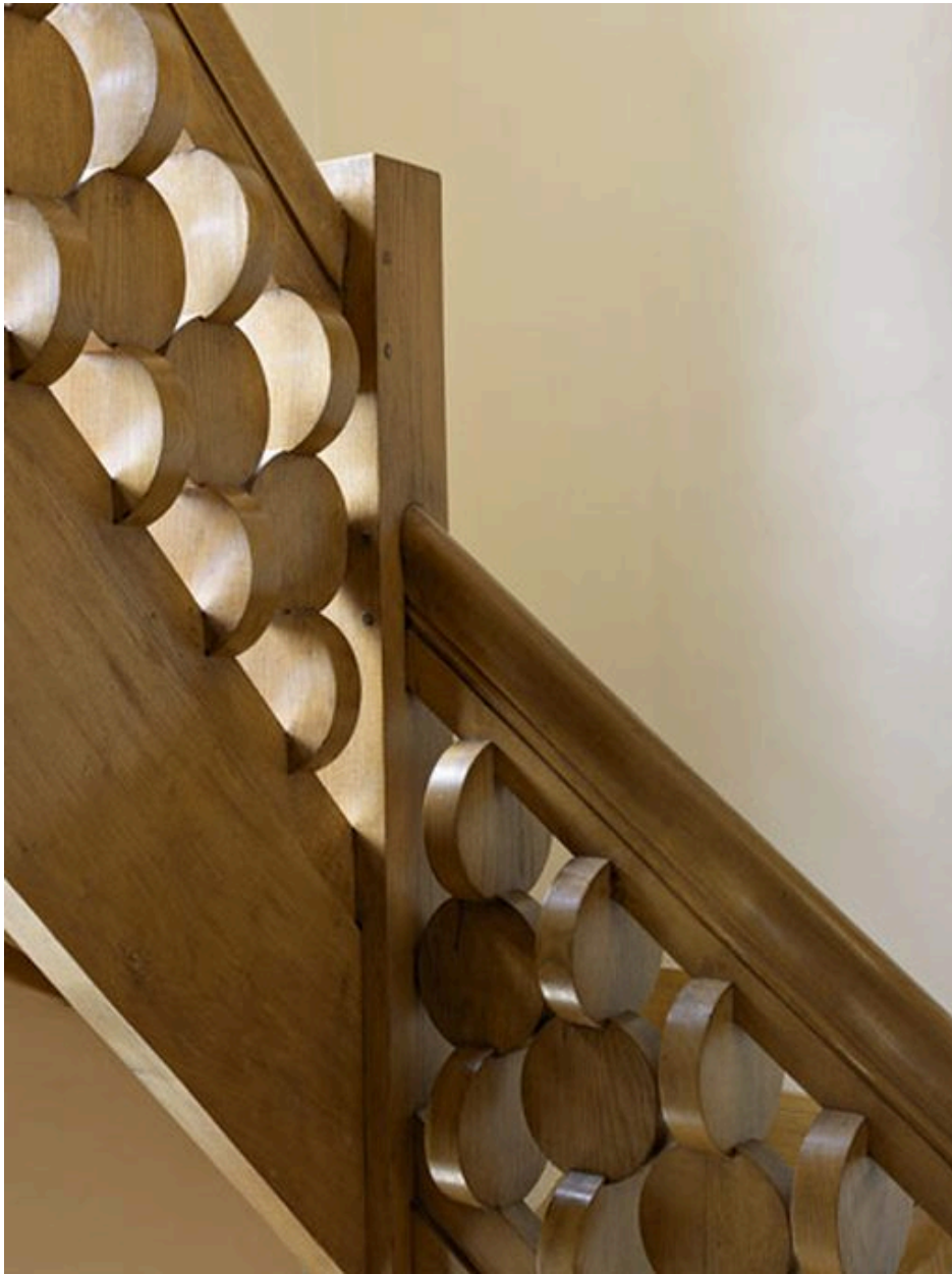
La rampe d'escalier
