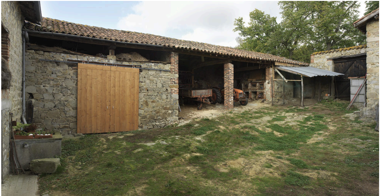
Vue d'ensemble des bâtiments ouest, depuis l'intérieur de la cour.
