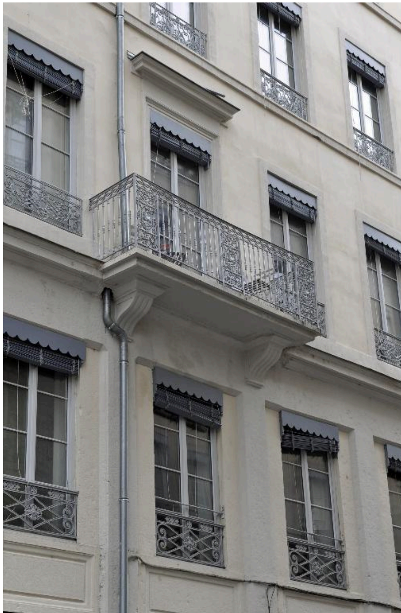
Elévation latérale : balcon du deuxième étage
