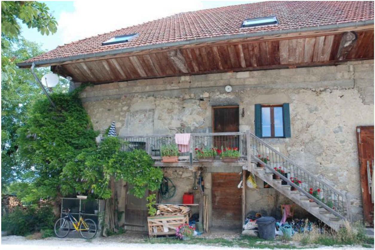
Vue de l'habitation.
