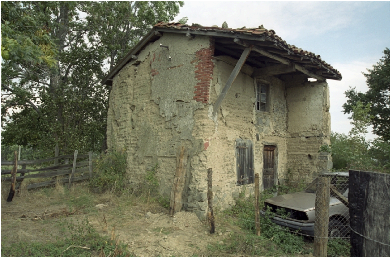
Cezay, Prandière (1987 A1 13), type C1. Vue d'ensemble du logis.
