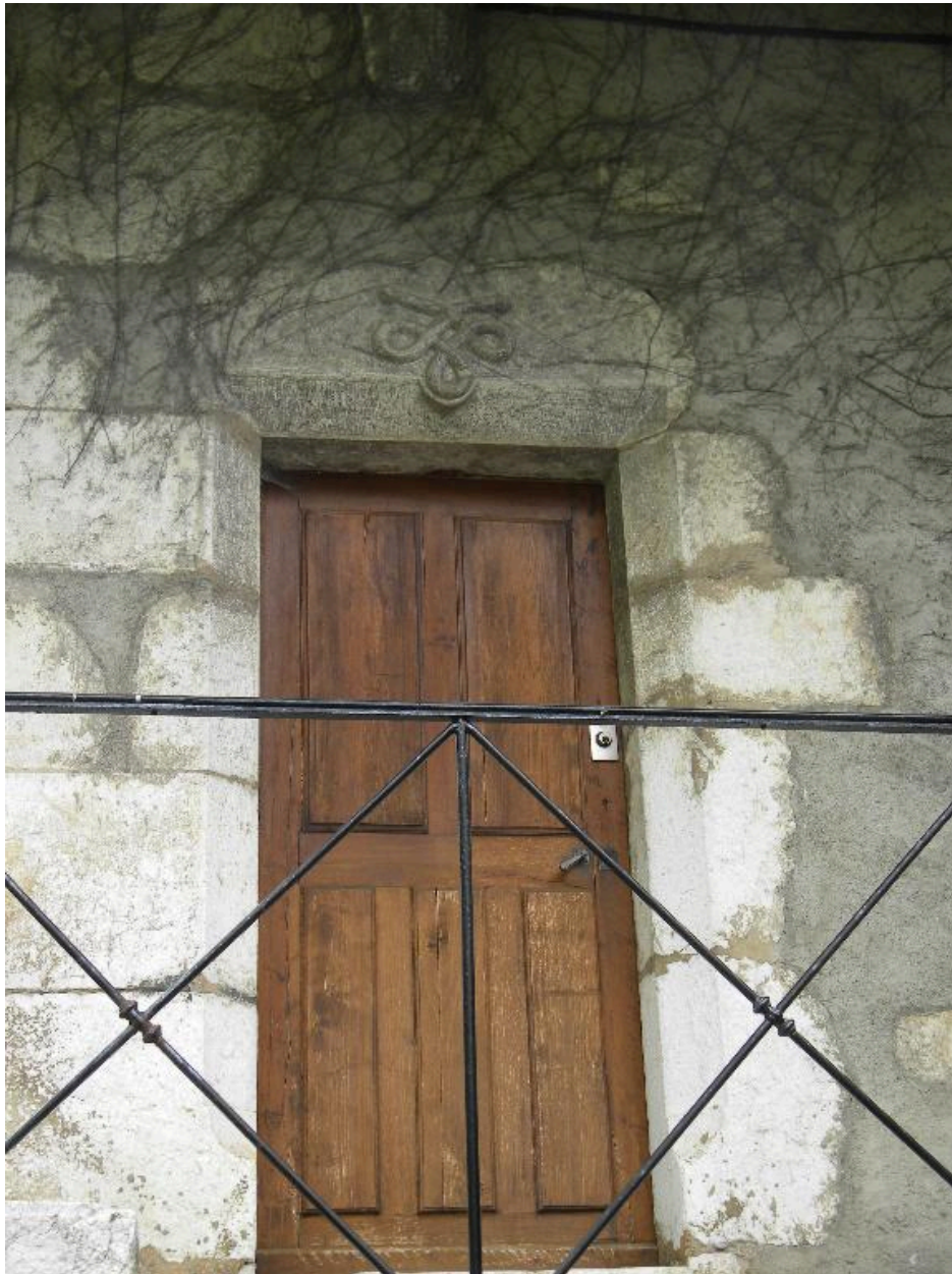
Vue de la porte du logis.
