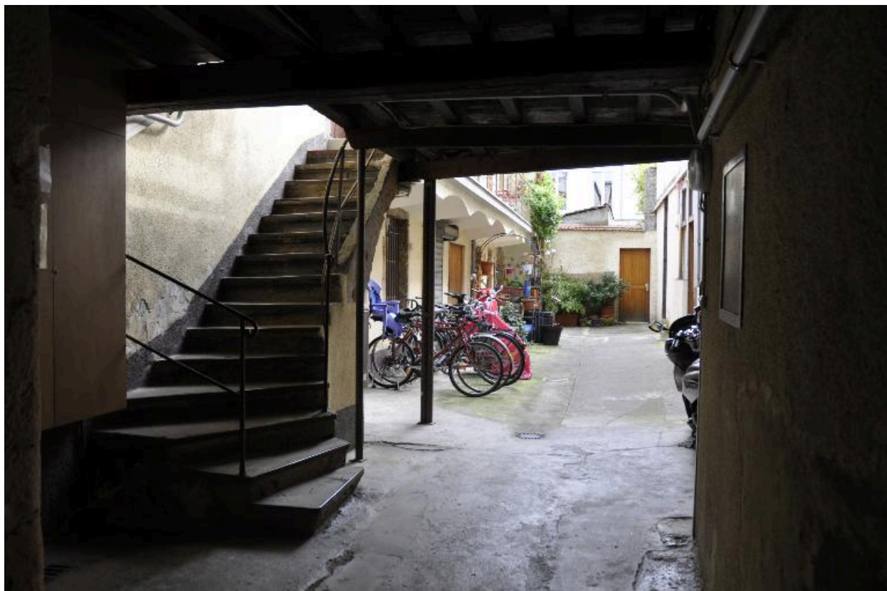
Vue de l'escalier
