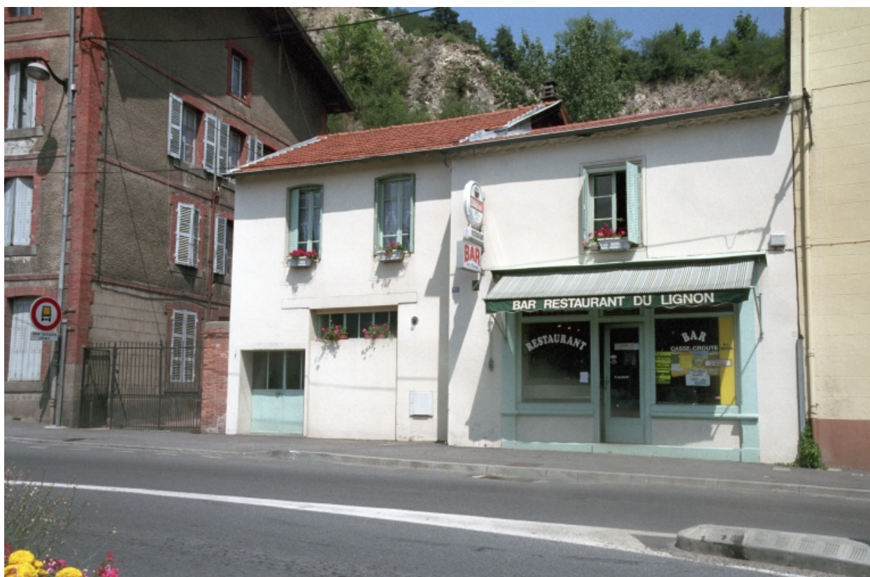
Boën, îlot 17, Lyon (rue de) 95a et 95b. Vue générale de la façade sur rue.
