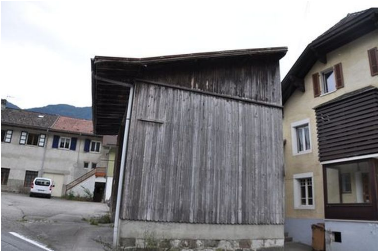
Remise donnant sur la cours de la scierie
