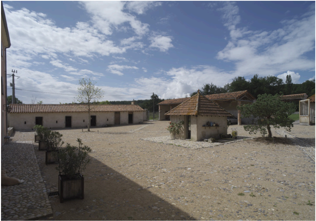
Vue d'ensemble de la cour depuis le sud-ouest.
