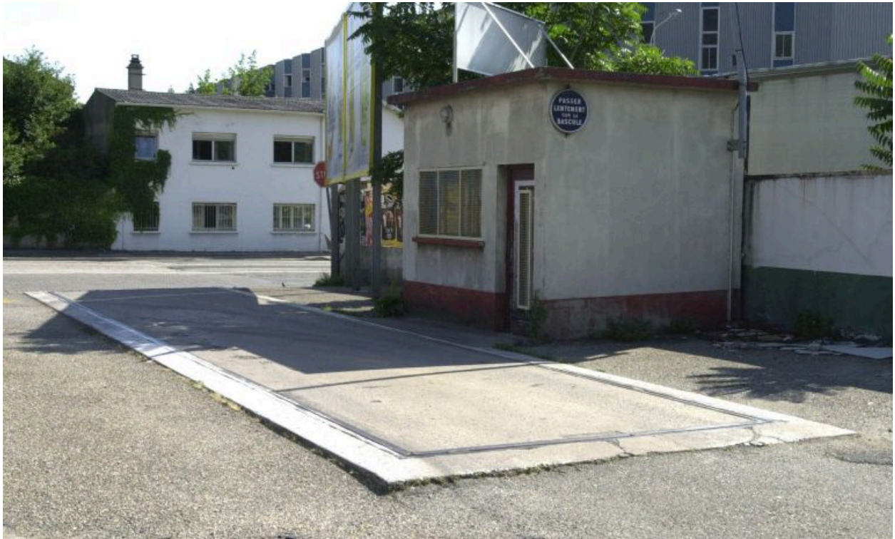
Vue générale depuis le sud-ouest
