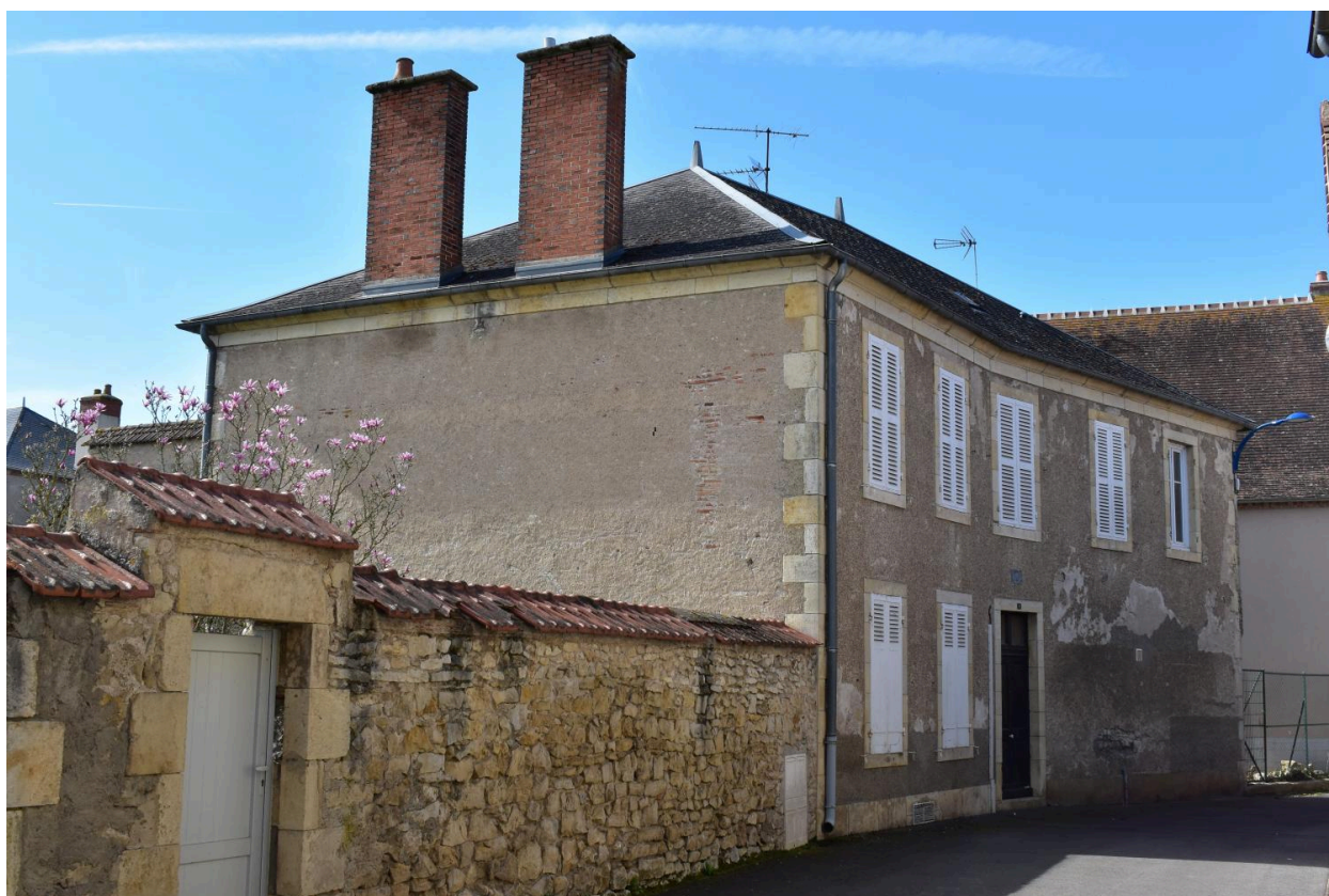
Vue générale du nord-est.
