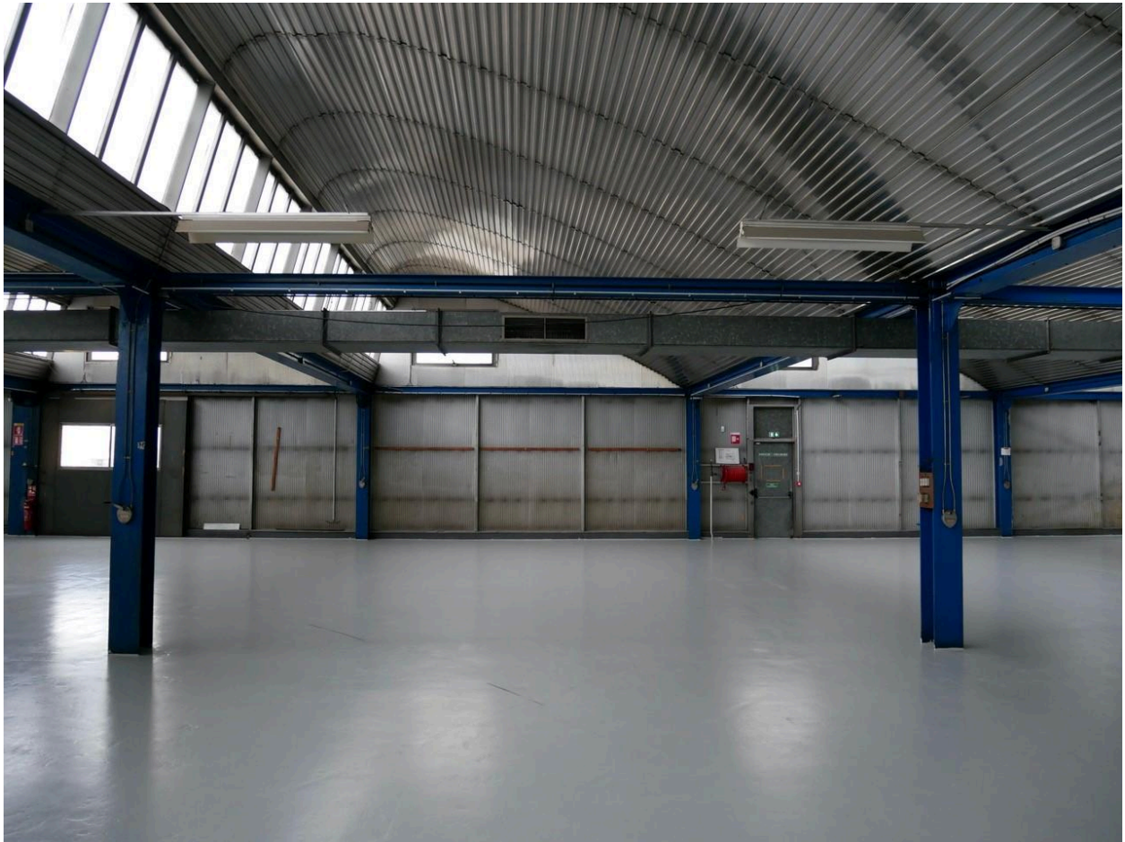
Vue intérieur détail shed
