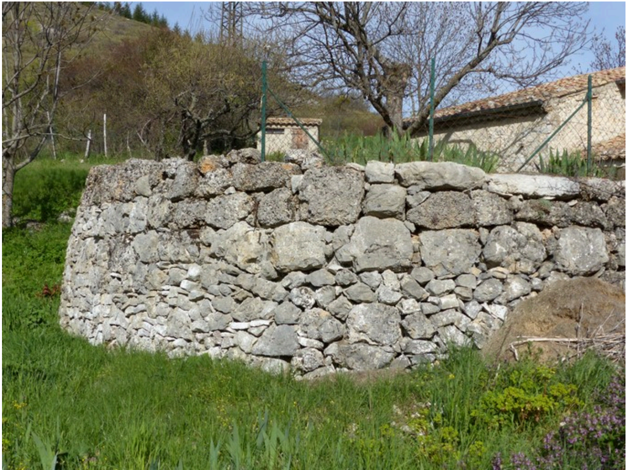
Mur de soutènement d'un jardin, ferme au quartier de la Clastre.
