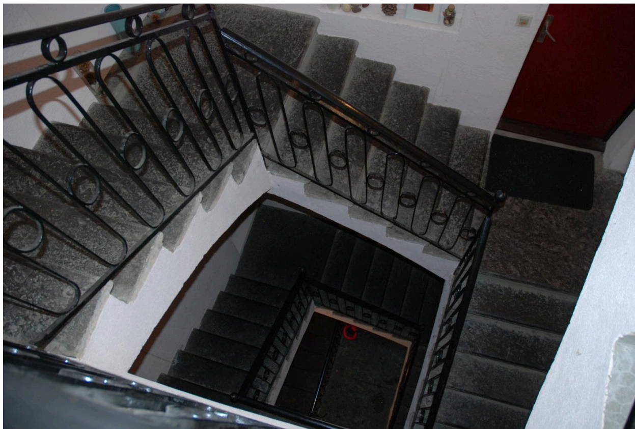
Maison, immeuble, 67 à 73 rue Louis Blanc-Pinget (2018 E1 1259). Vue intérieure de l'escalier.
