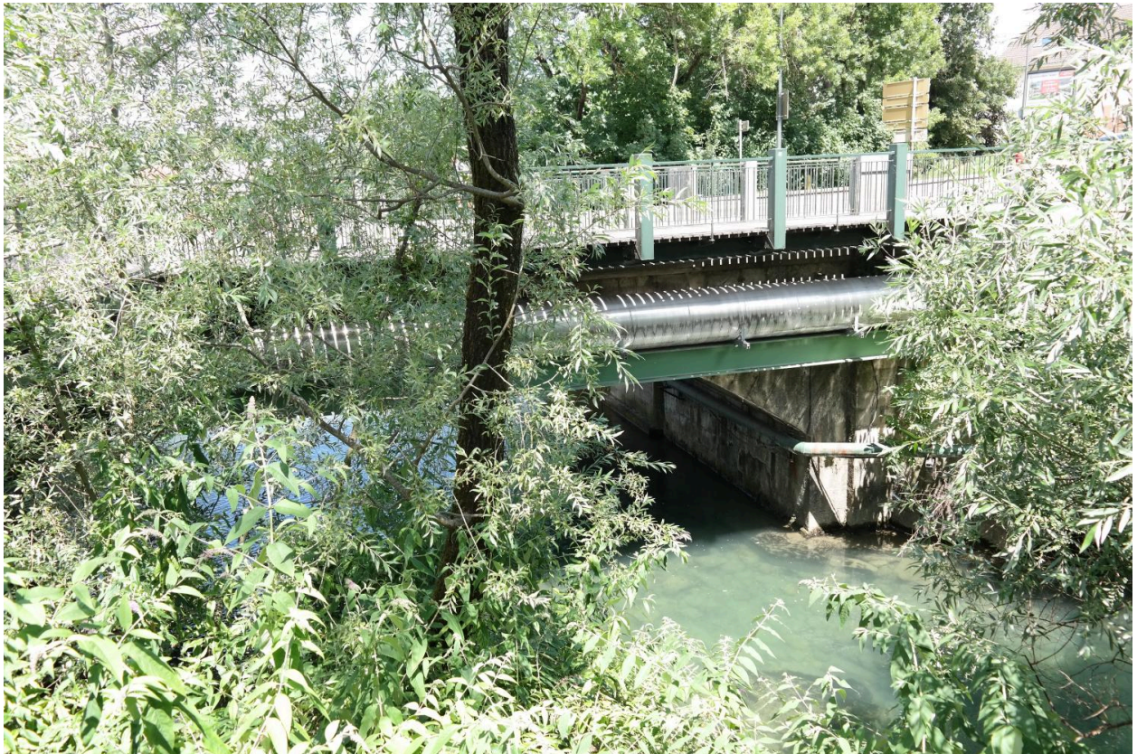
Pont de Cran, vue de la face amont
