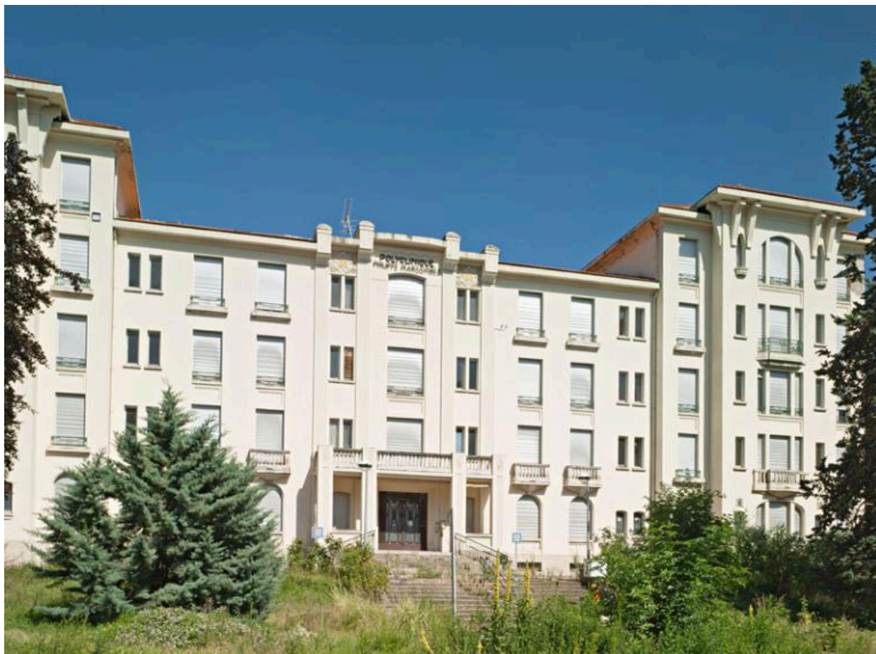
Hôtel-Dieu de Clermont-Ferrand. La polyclinique, façade principale (ouest).
