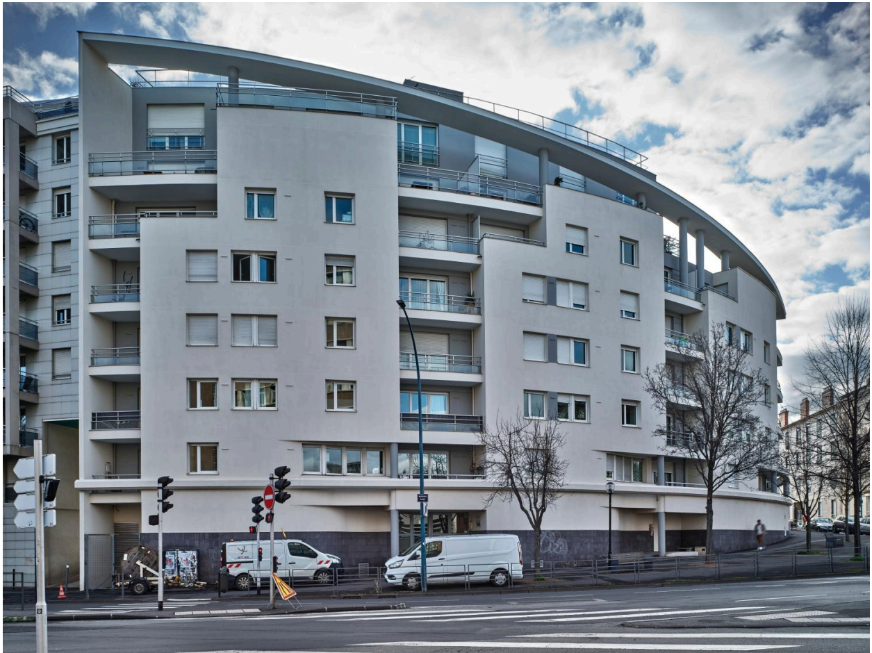
Façade sur le carrefour des Paulines
