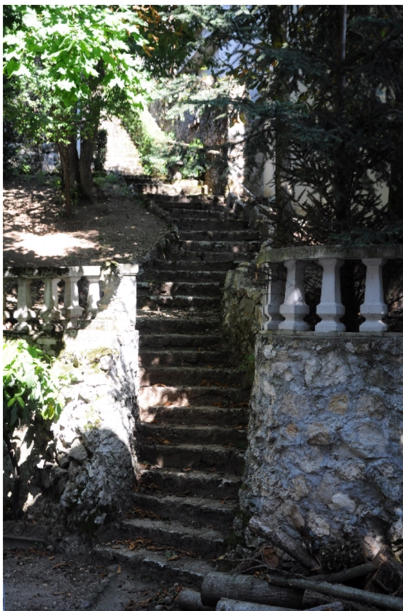
Escalier vers le bd Perrin
