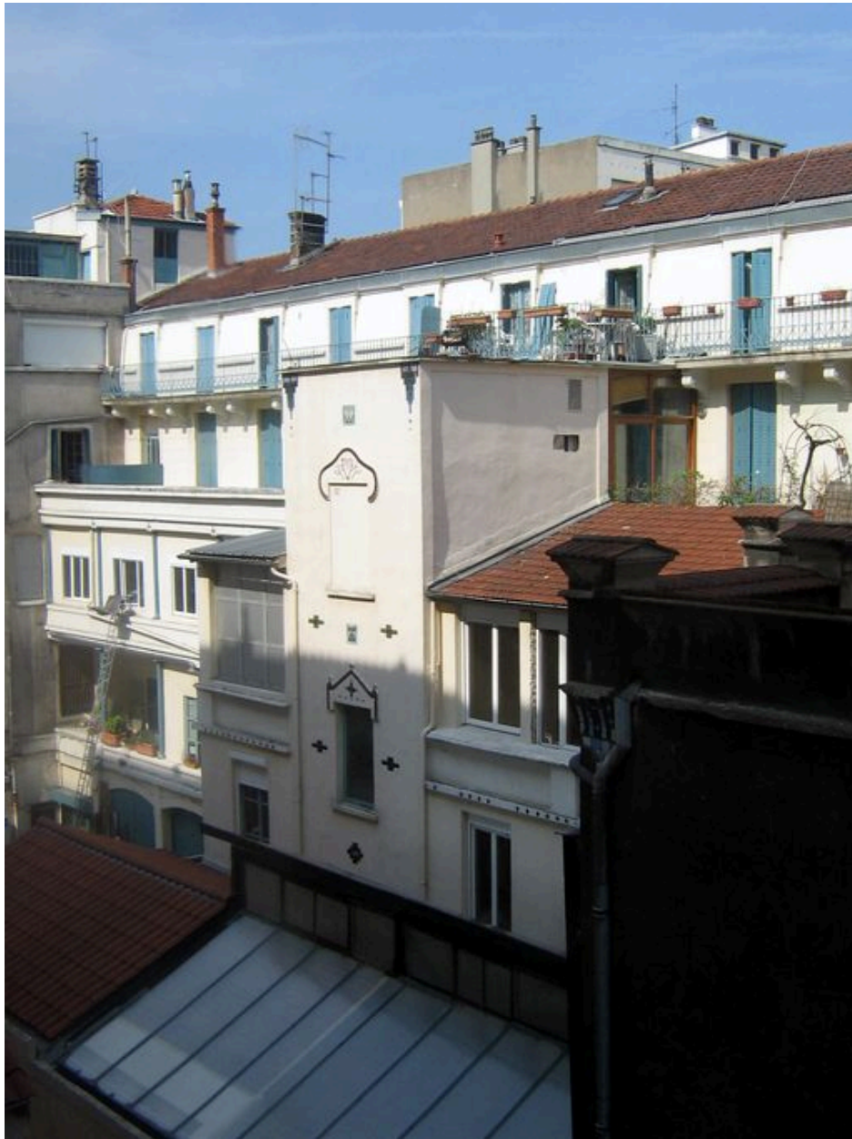
Vue d'ensemble de la cage d'escalier centrale portant le décor de céramique, depuis le nord
