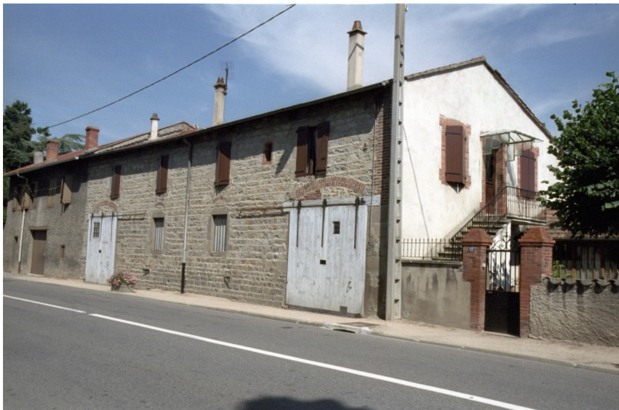
Boën, îlot 11, RN 89, 12. Vue générale de la façade sur rue.
