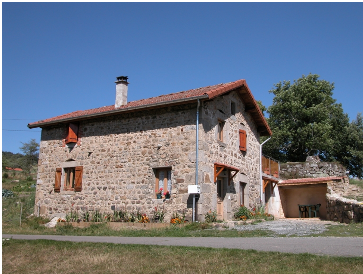
Vue d'ensemble du moulin (bâtiment nord), transformé en habitation.
