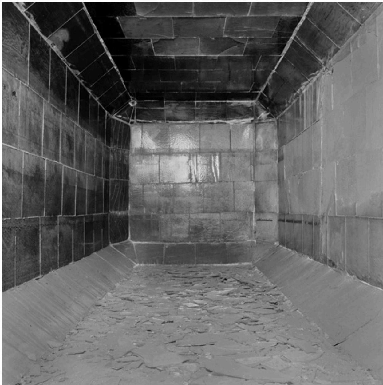
Intérieur des cuves à vin recouverte de carreaux de verre
