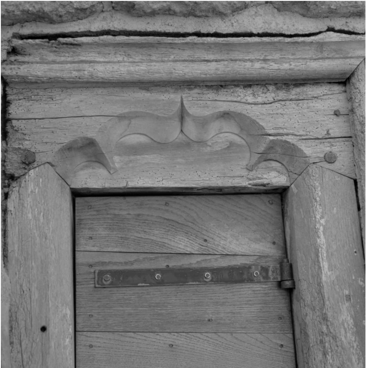
Détail du linteau en double accolade de la porte nord (accès au clocher).
