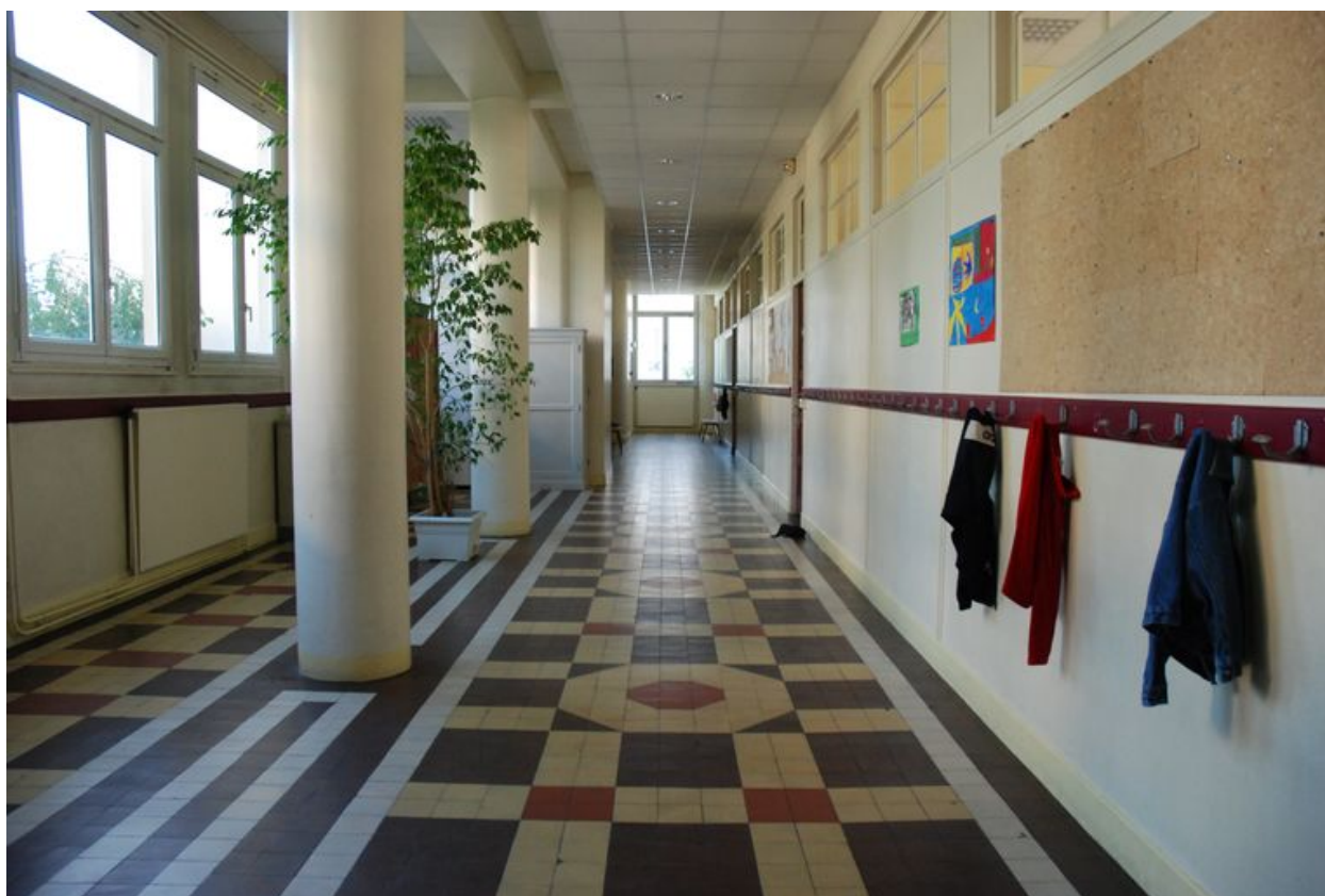
Vue sur l'aile Nord du premier étage
